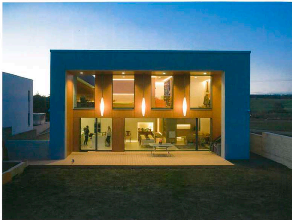
Protégée par les éléments de façade en avancée, la terrasse en bois est un lieu convivial utilisable en toute saison.
